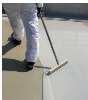
Application Couche de roulement
