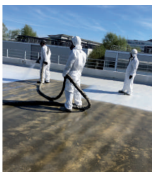
Projection étanchéité après primaire
