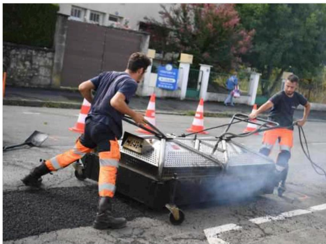
L'enrobé est chauffé à 250 degrés pendant 8 minutes puis raclé pour ensuite être réutilisé. Photo Romain Longieras
