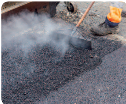
② Scarification des enrobés
